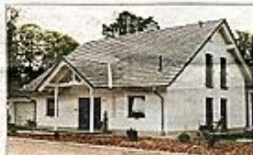
Ein der vielen Referenzobjekte der Firma Ausbau GmbH Liebertwolkwitz im Raum Leipzig.
